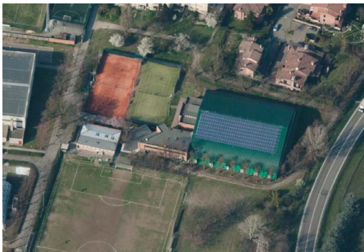
Veduta aerea del plesso sportivo ed indicazione della Palestra oggetto di intervento
