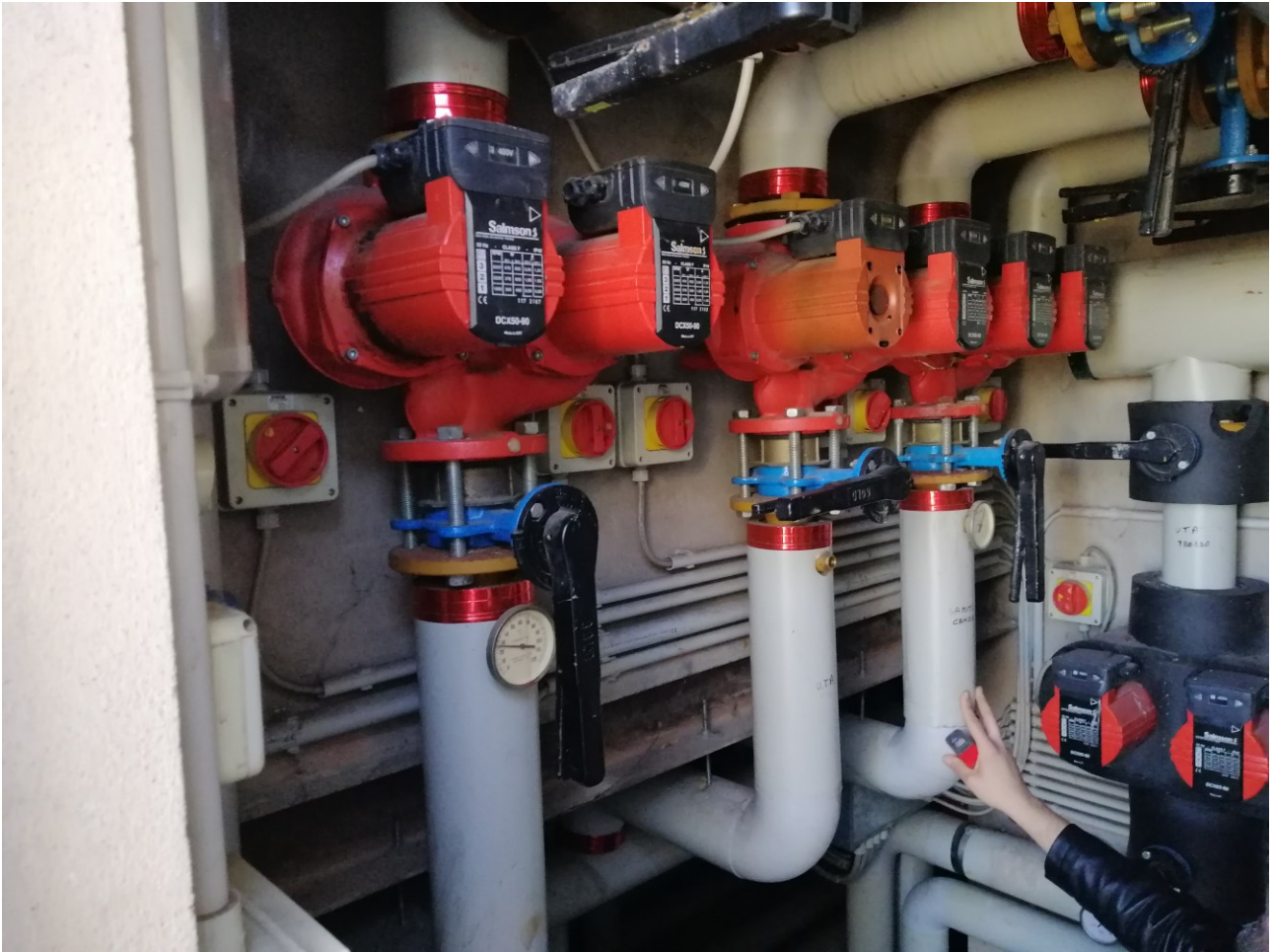
Figura 9 Sottocentrale termica
