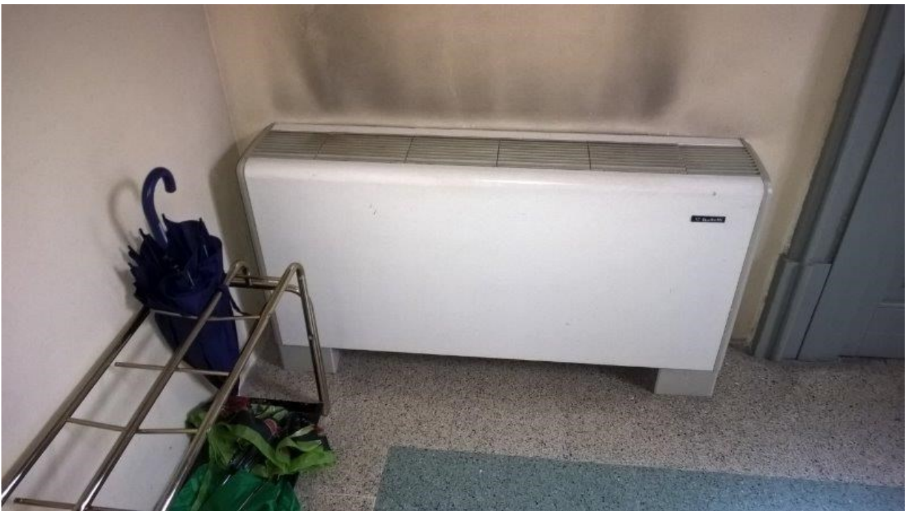
Figura 6 Ventilconvettore ingresso
