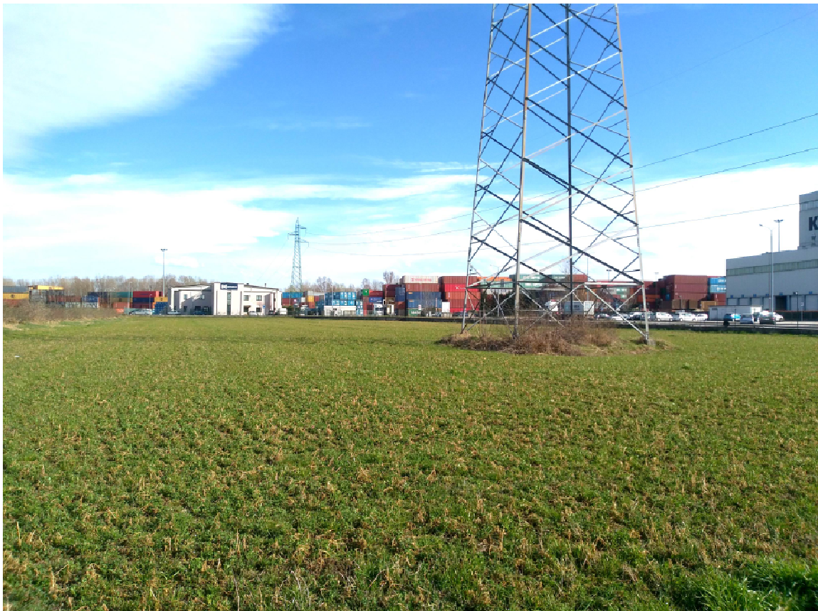
Sito di Via Corradini
