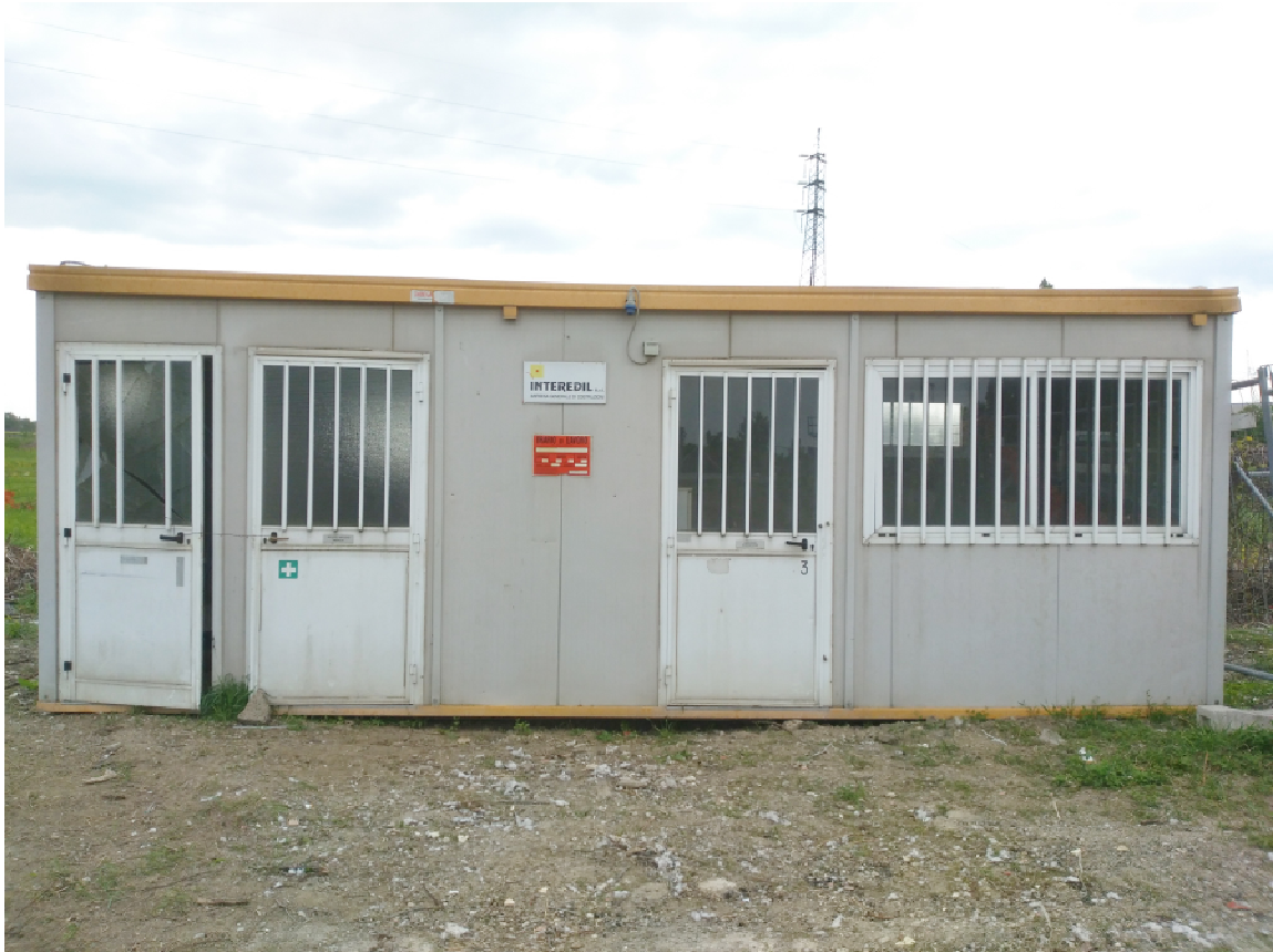
Box 3 fronte Est
