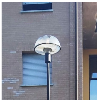
Esempio danneggiamento apparecchi illuminanti Parco Andreoli e Via Paduli
