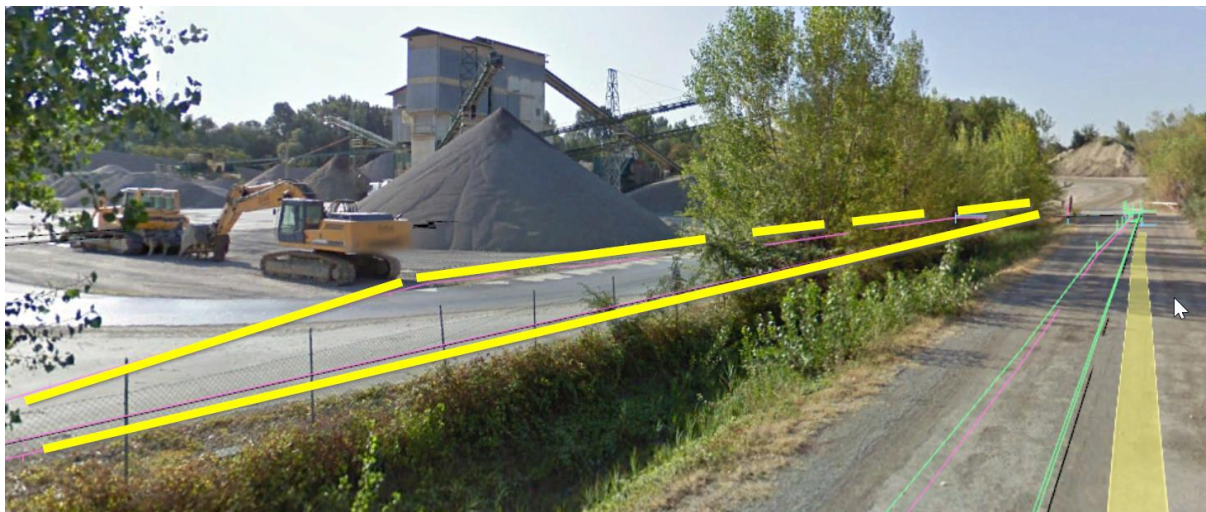
L'area in esproprio (linea gialla) sul mappale 11 vista dal piano strada.
