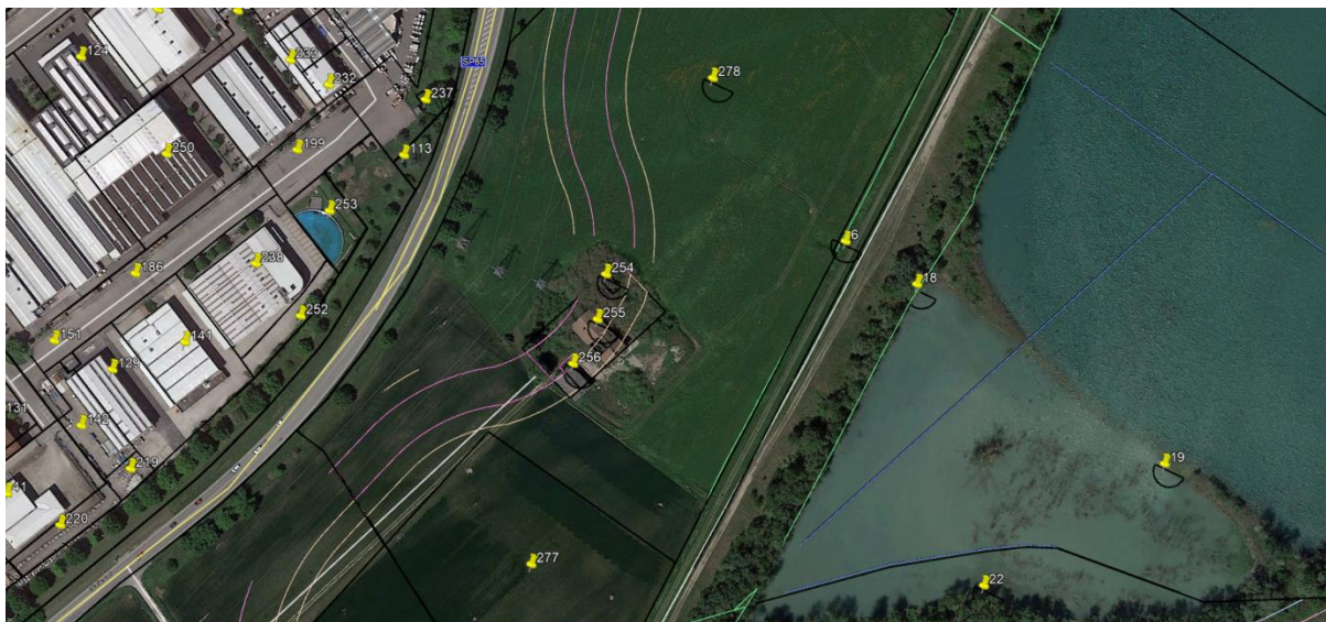
Il fabbricato "centrato in pieno" dall'argine.
