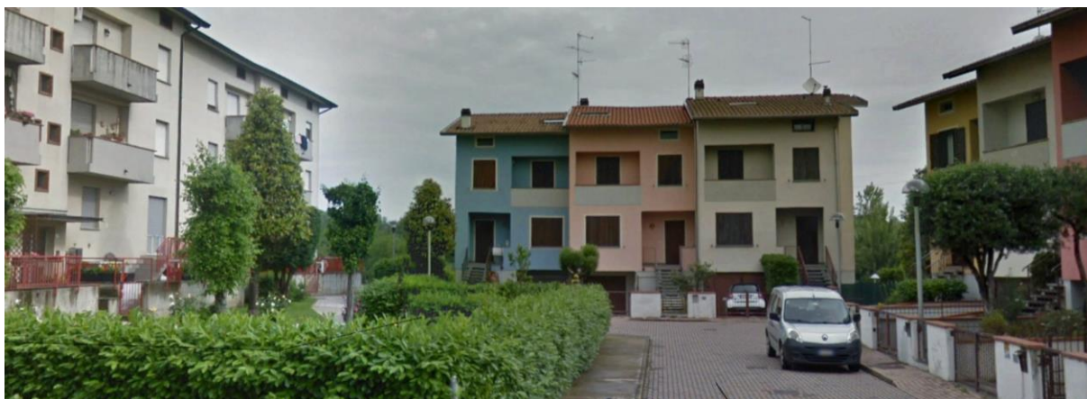
I fabbricati interessati visti da Strada Chiesa Marzaglia. In centro le tre case a schiera più vicine all'argine.d
