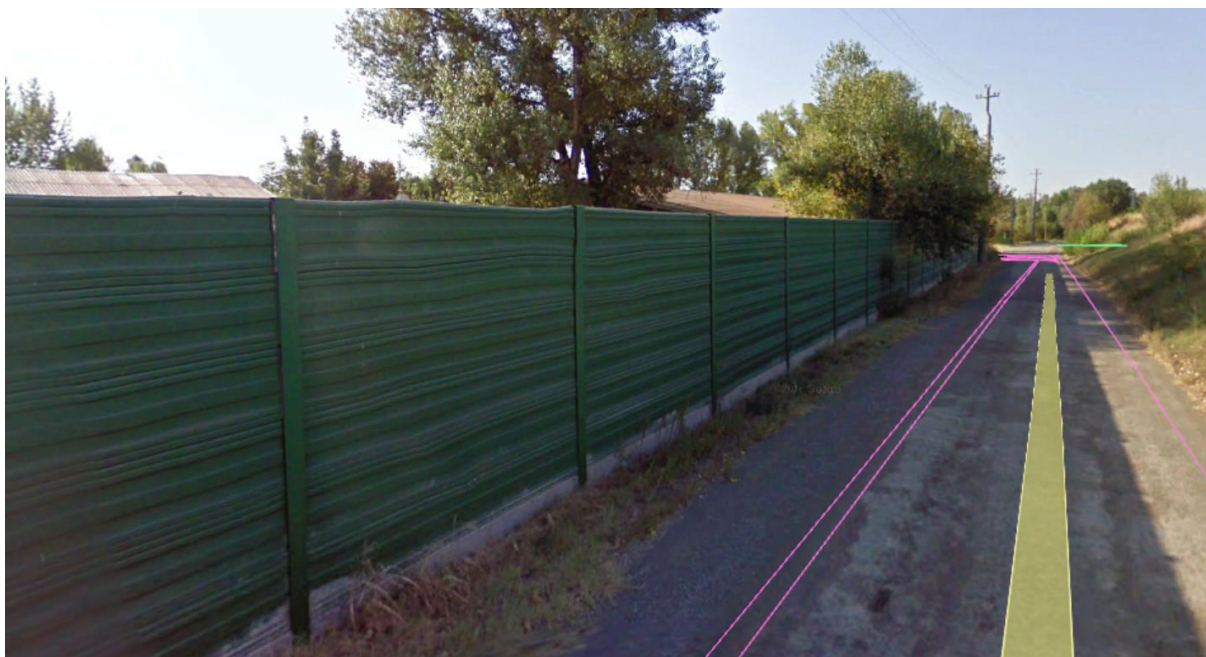
Su retro, lato esproprio, lungo la stradella laterale a ovest.
