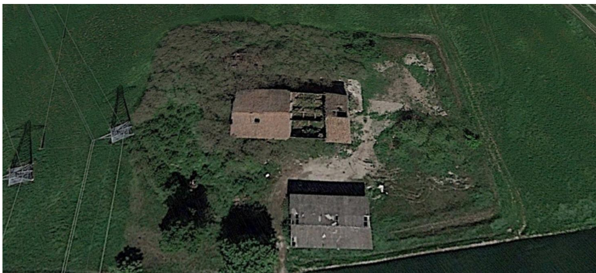
Vista satellitare: constano due corpi di fabbrica, il principale è aggredito da vegetazione e ha il tetto parzialmente crollato.
