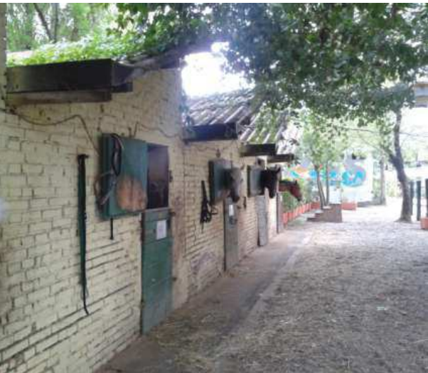
LATO OVEST (VISTA DA NORD)
