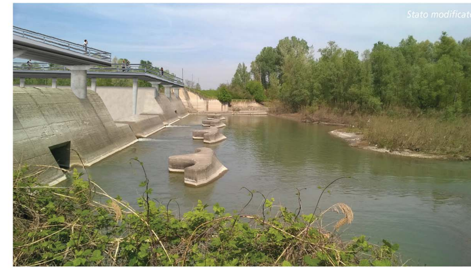
4. Intervento A: trasformazione del manufatto di regolazione.
