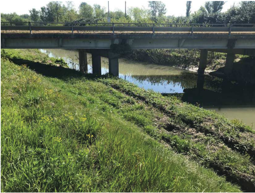
Foto 11 – Sponda idraulica sinistra
