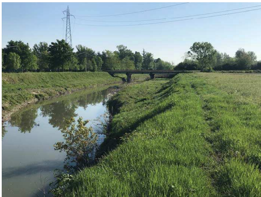
Foto 2 –Vista lato monte
