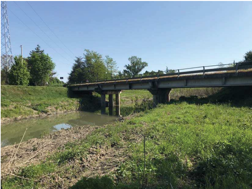
Foto 4 – Vista impalcato lato monte
