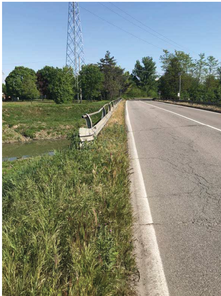
Foto 10 – Guard rail, cunetta e pavimentazione
