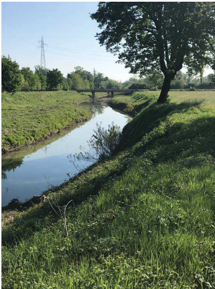
Foto 1 –Vista del ponte esistente sul Torrente Tresinaro (lato monte)
