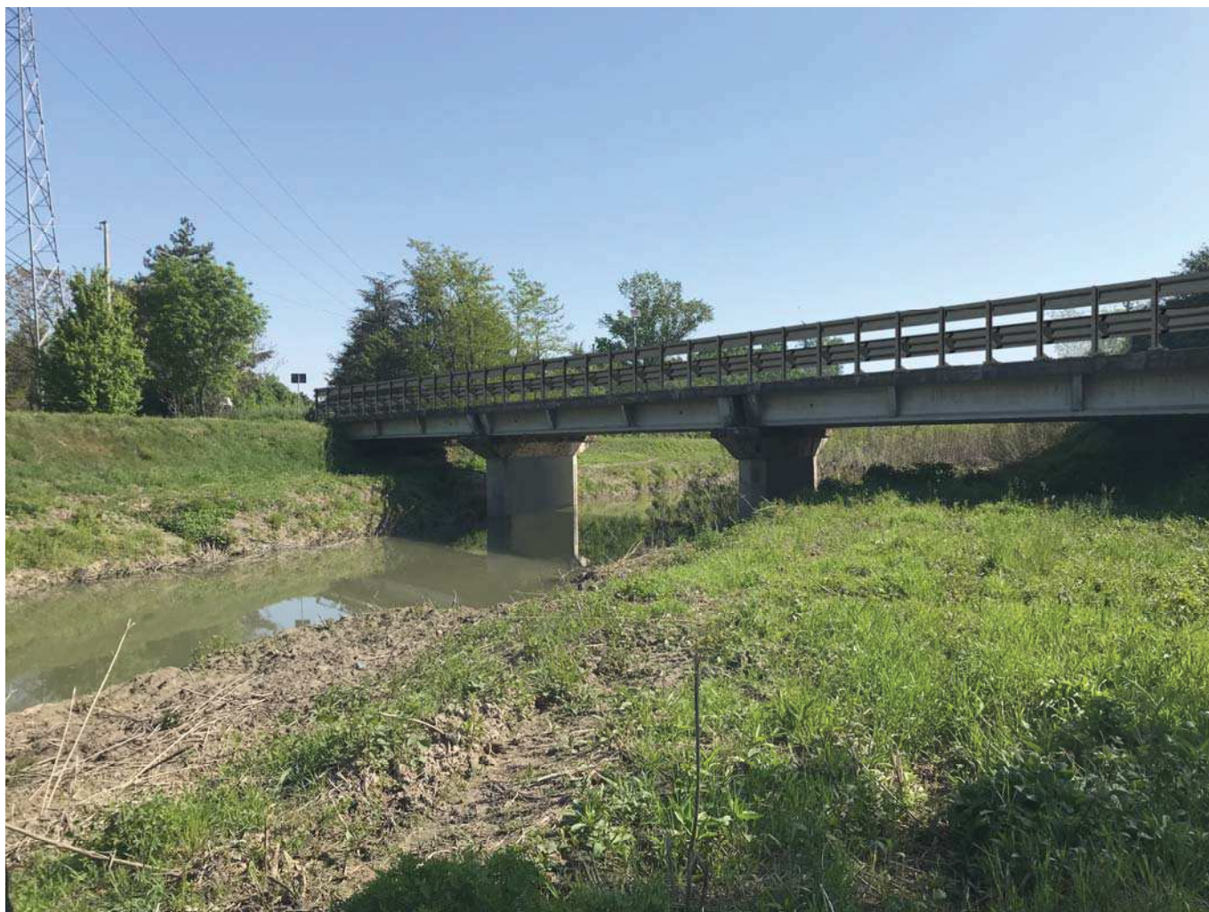
-Manutenzione straordinaria del ponte sul Torrente Rodano: vista lato valle-
