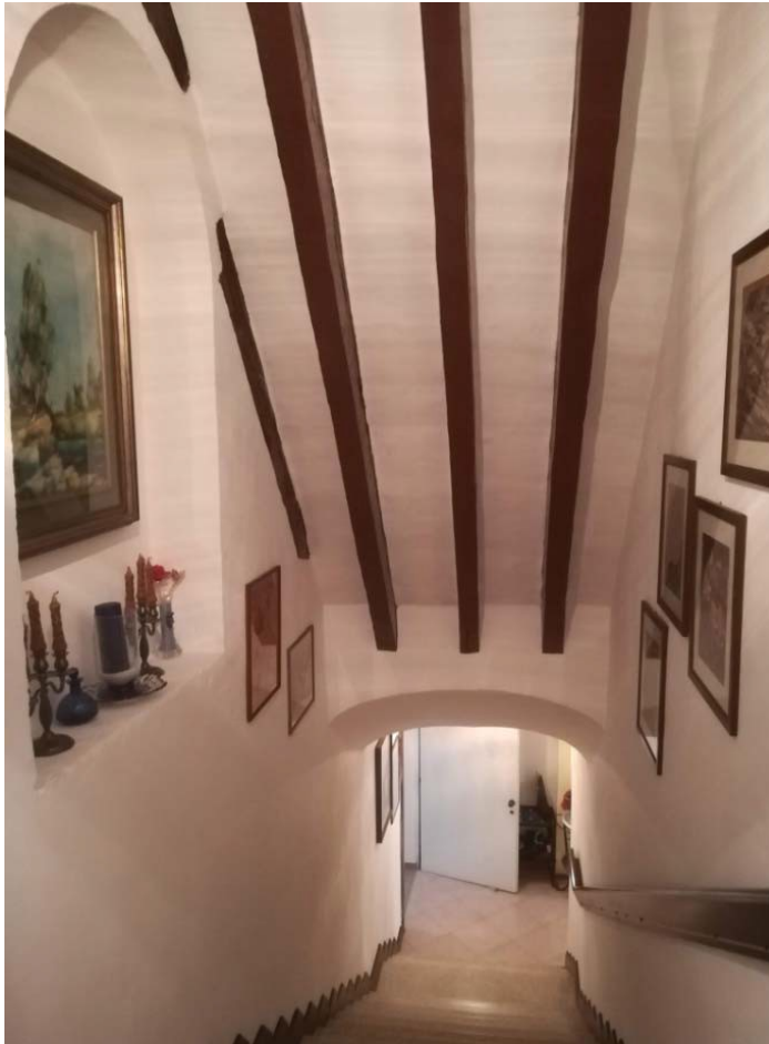
SCALA COMUNE PIANO TERRA
