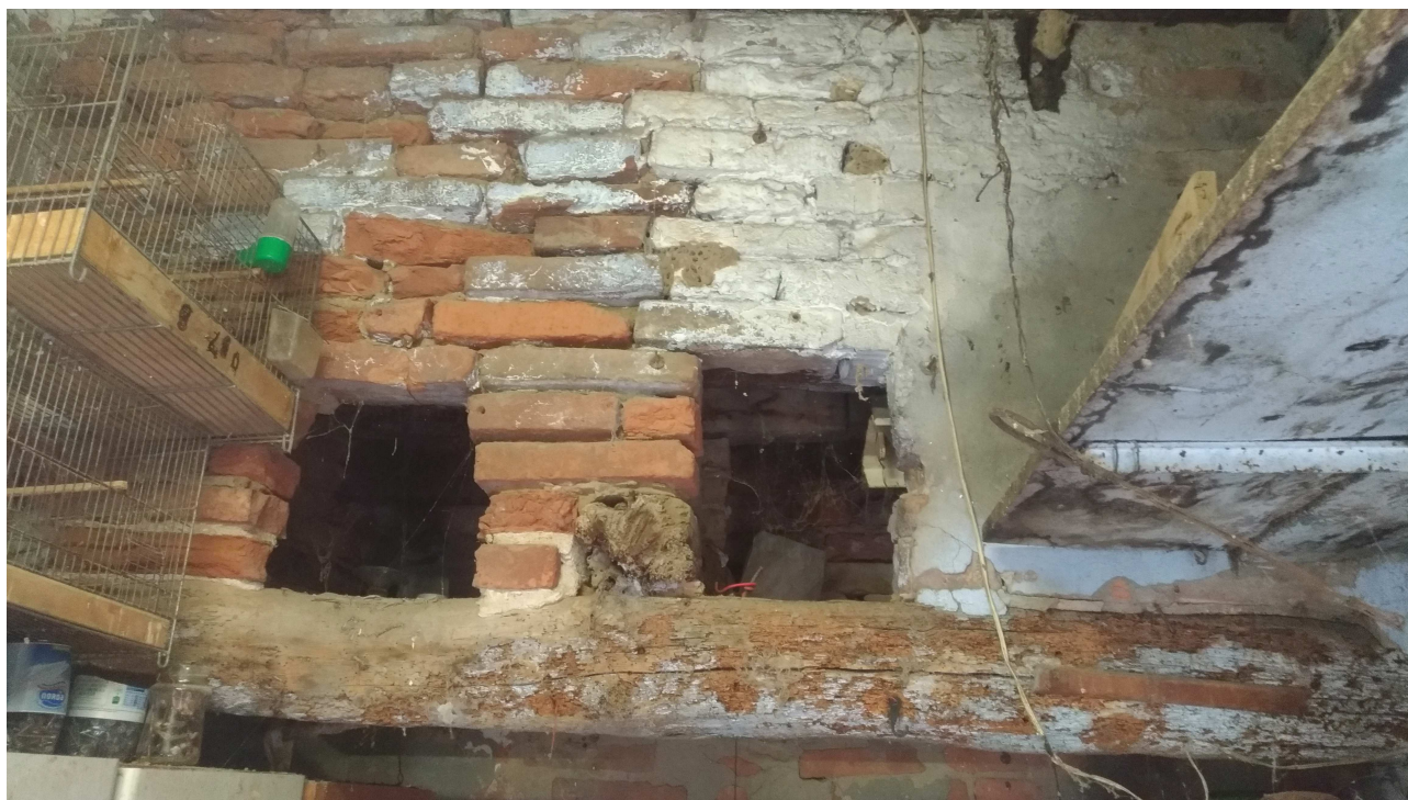
Foto 7: piano terra, locale cantina-ripostiglio
