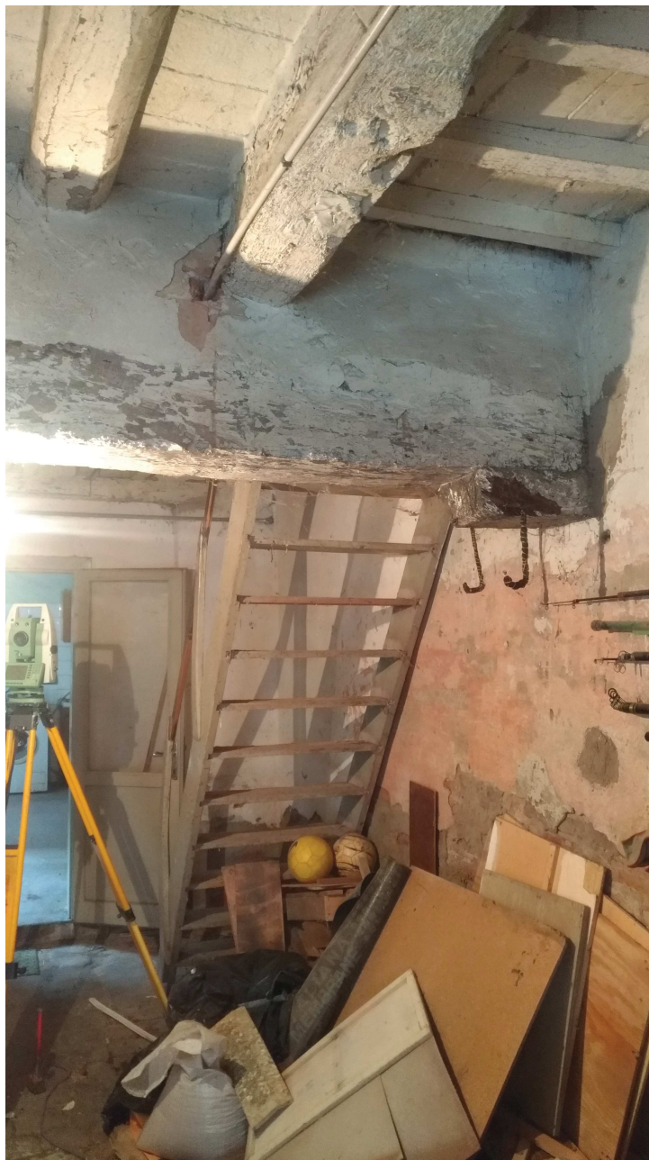
Foto 3: scala in legno che porta da piano terra al piano primo
