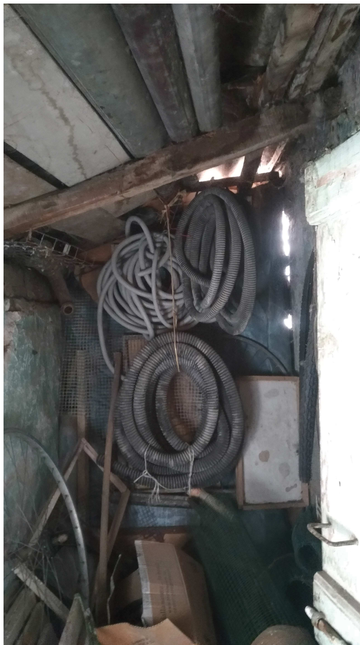
Foto 17: locale ripostiglio al primo piano (vedi foto n°10)
