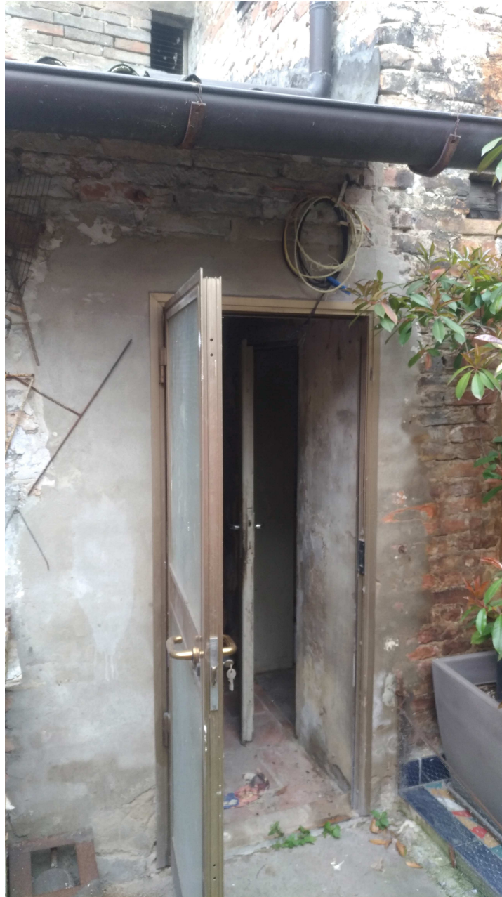
Foto 9: uscita su cortile di pertinenza
