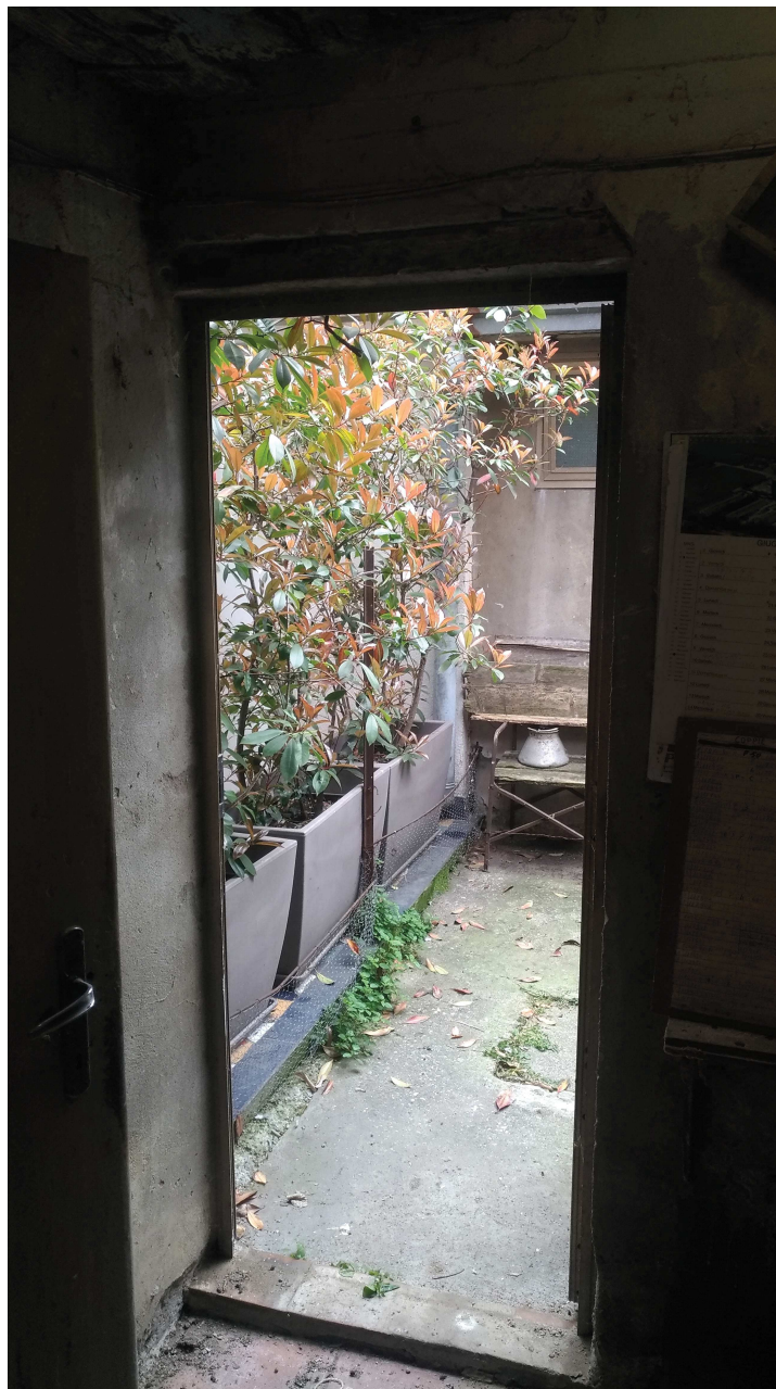
Foto 8: cortile di pertinenza con passaggio per wc esterno
