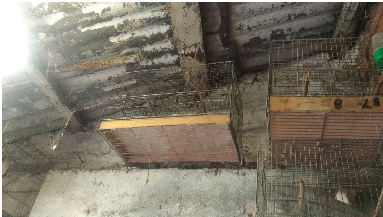
Foto 6: piano terra, locale cantina-ripostiglio
