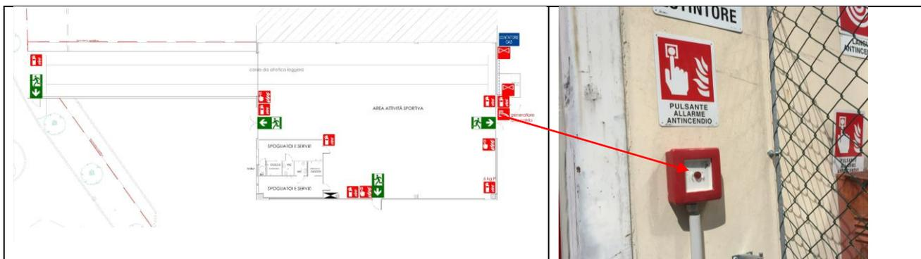
Figura 5 - posizione pulsante di sgancio elettrico generatore di aria calda
