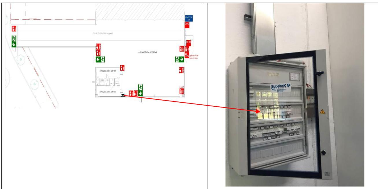
*Figura 11 - posizione quadro elettrico generale*
