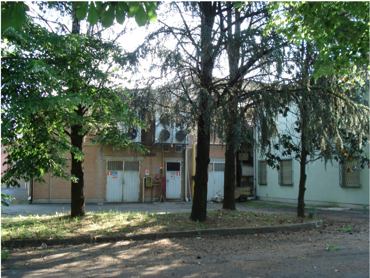
Foto 7. Vista del complesso dal fronte Ovest
