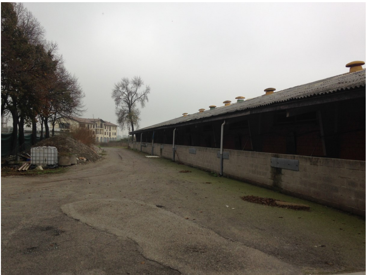
Foto 13.1 Le porcilaie, fronte Ovest
