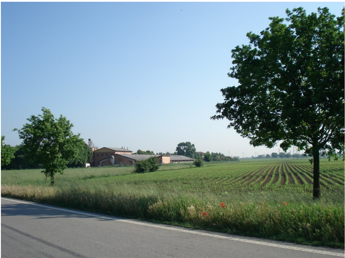
Foto 19. Il complesso Lato Sud
