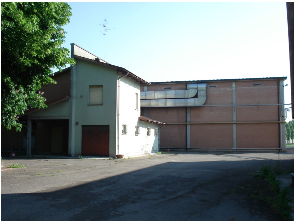
Foto 8. Il magazzino (lato Sud)
