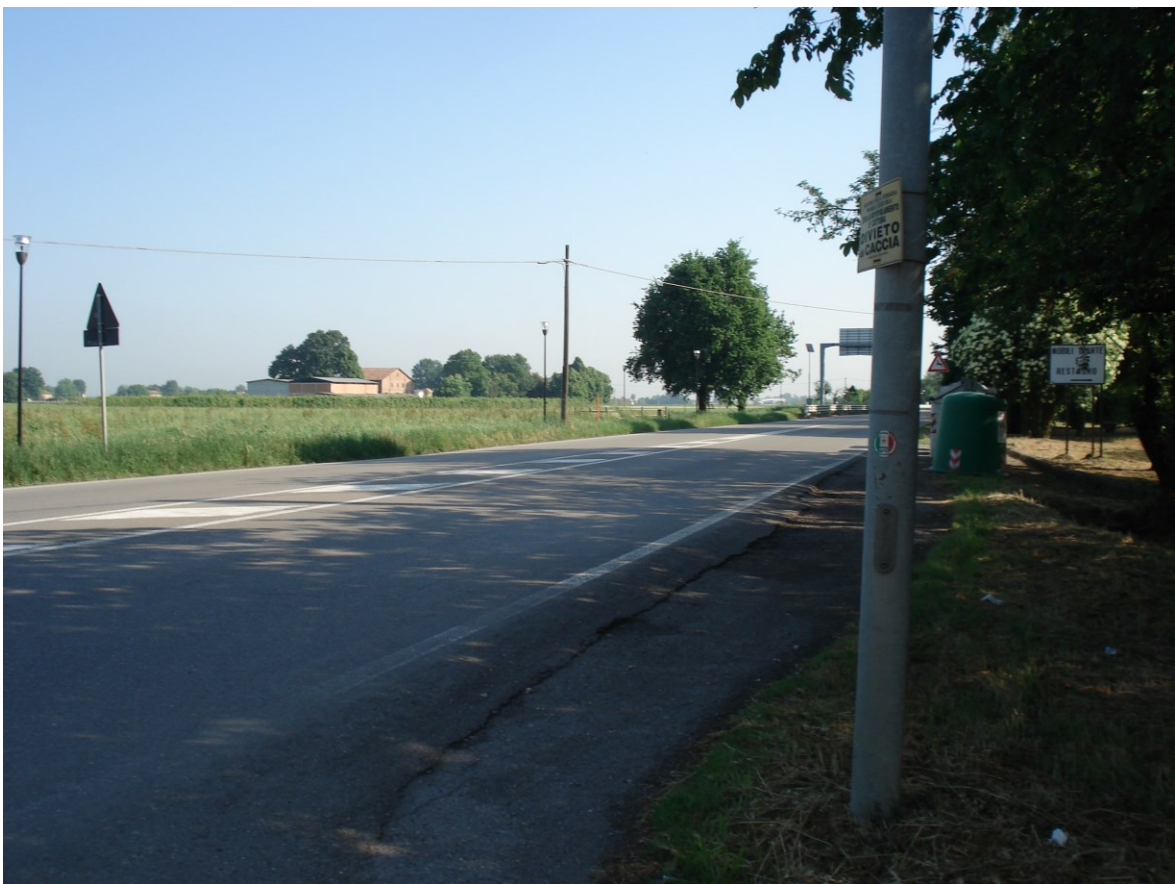
Foto 2. La Strada Provinciale 85 Rubiera - Campogalliano
