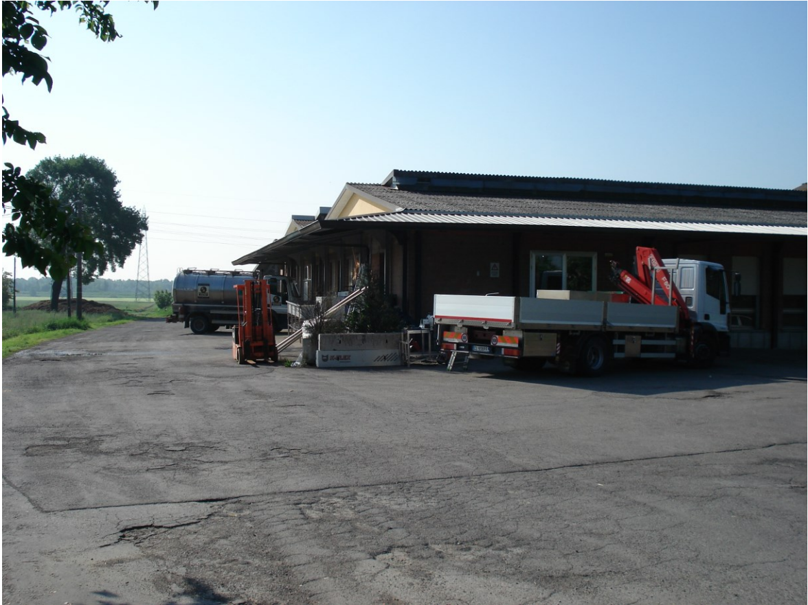
Foto 16. Il complesso Lato Nord
