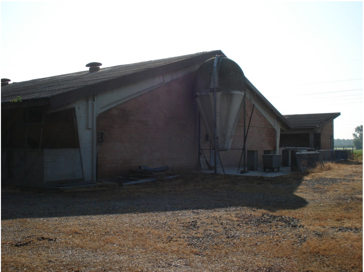
Foto 12. Le porcilaie, fronte Sud
