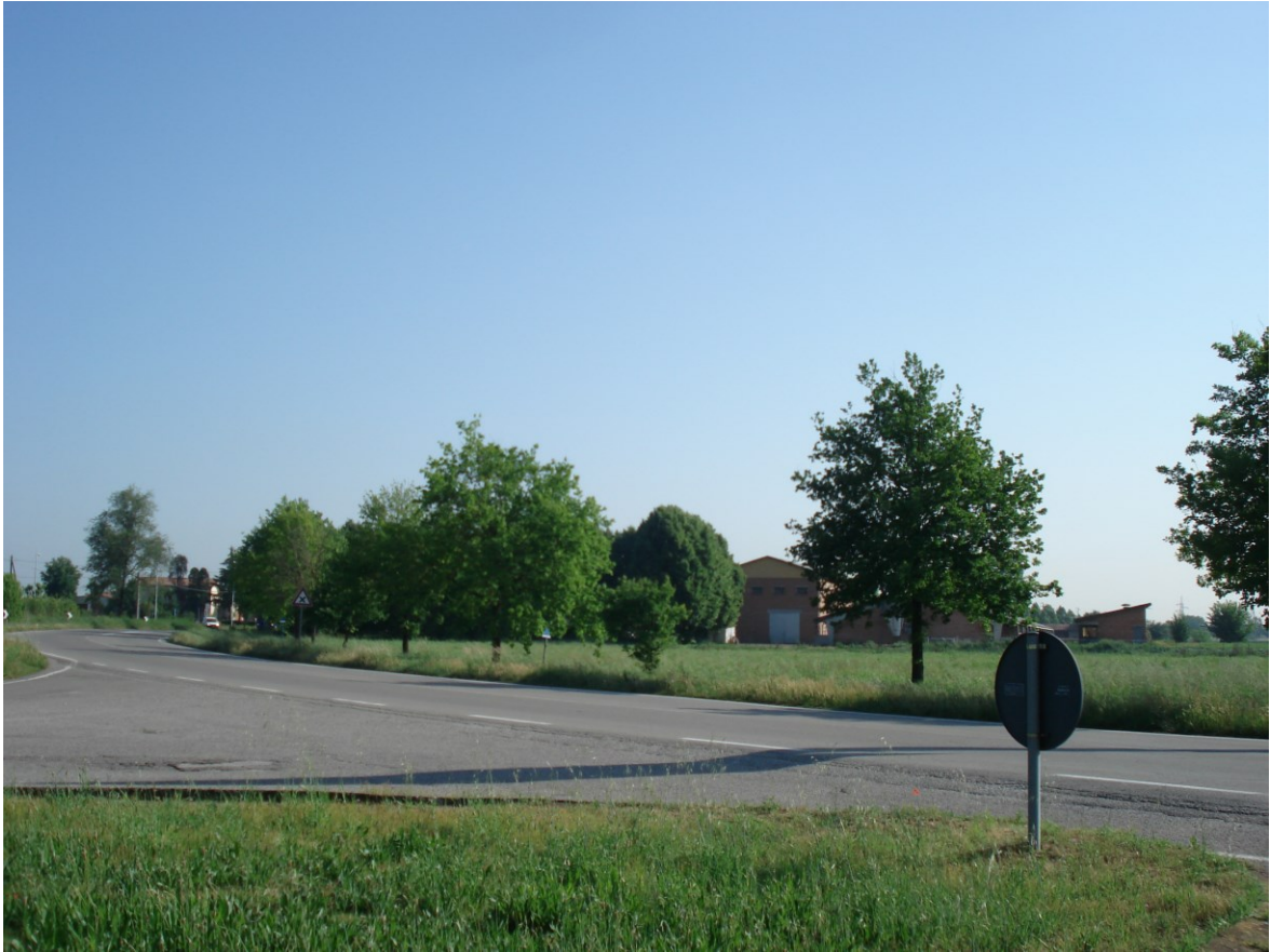
Foto 18. Il complesso Lato Sud
