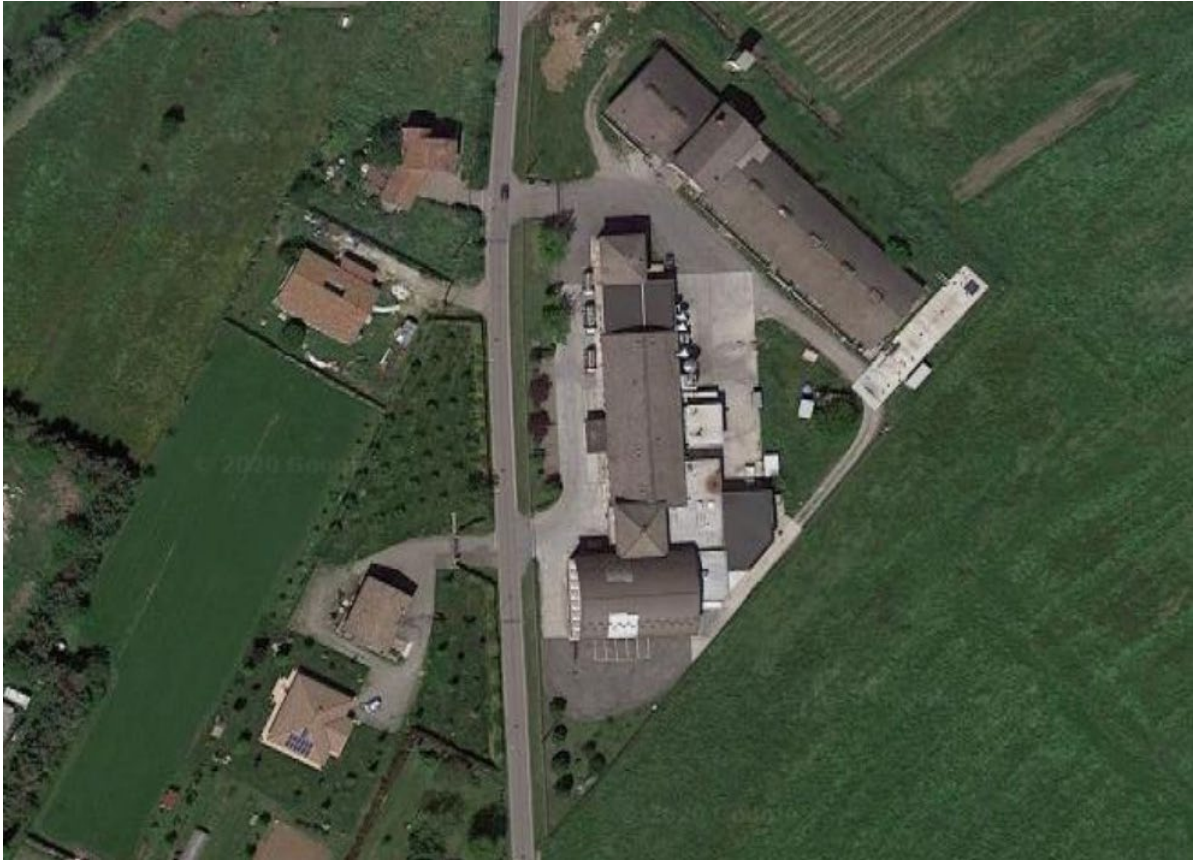
Latteria Soc. Nuova 2000 – Cavriago (RE)
