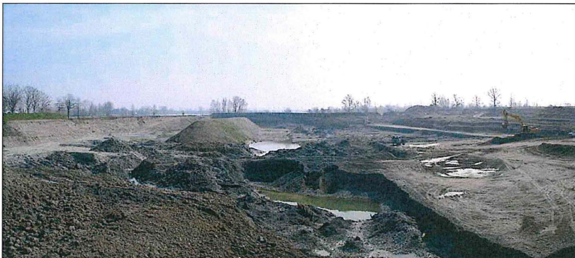
Foto n° 1 – Panoramica area estrattiva vista da Ovest
