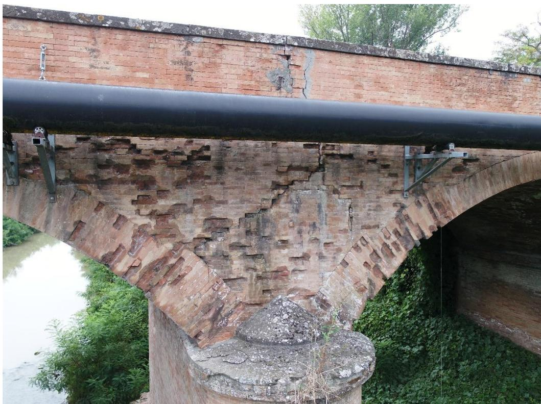
*Foto 4 - Lesioni sulla muratura nelle zone di parapetto e timpano (Prospetto a Valle) con fenomeni di esfoliazione sui mattoni*
