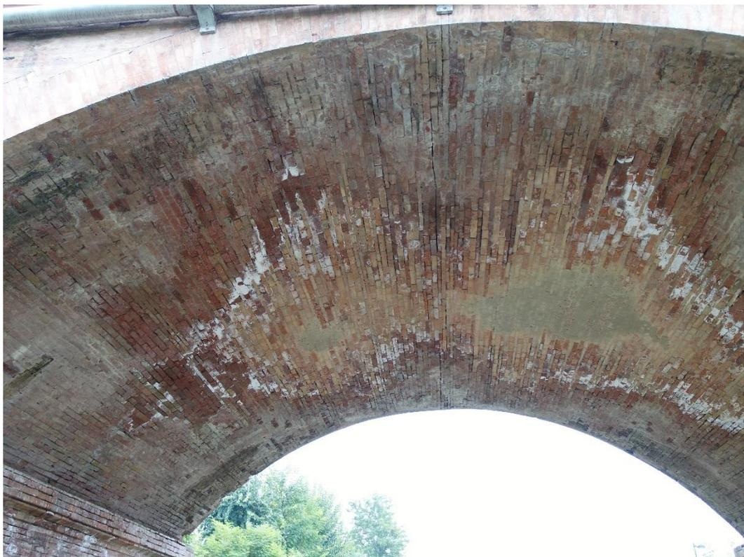
*Foto 5 - Fenomeno di Efflorescenza all'intradosso della volta*
