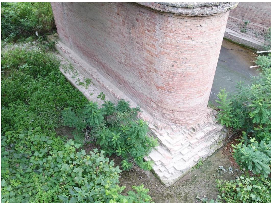
*Foto 6 - Erosione e distacco in fondazione*
