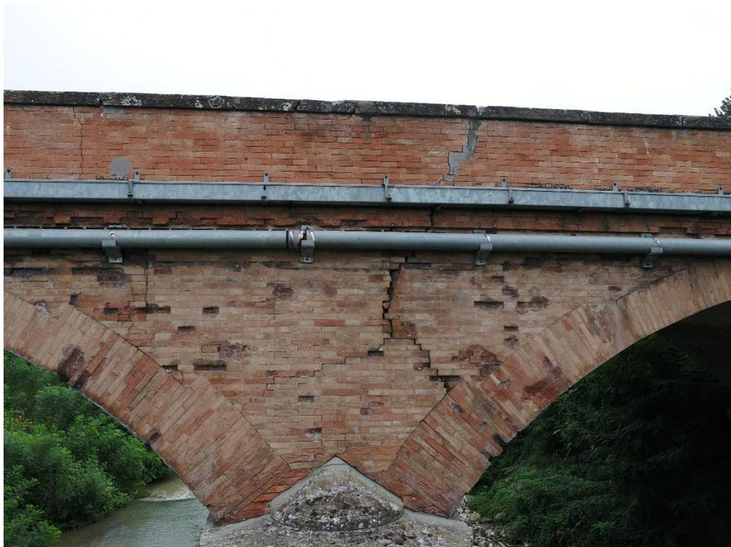
*Foto 3 - Lesioni sulla muratura nelle zone di parapetto e timpano (Prospetto a Monte)*
