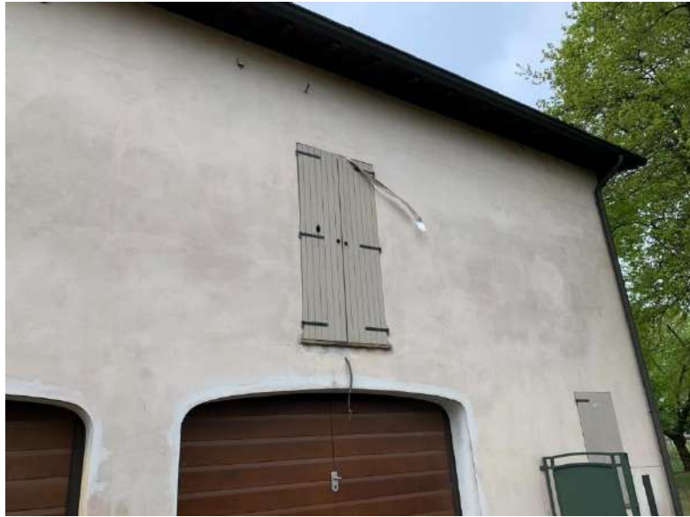
Edifici a contesto compresi nel "borgo"
