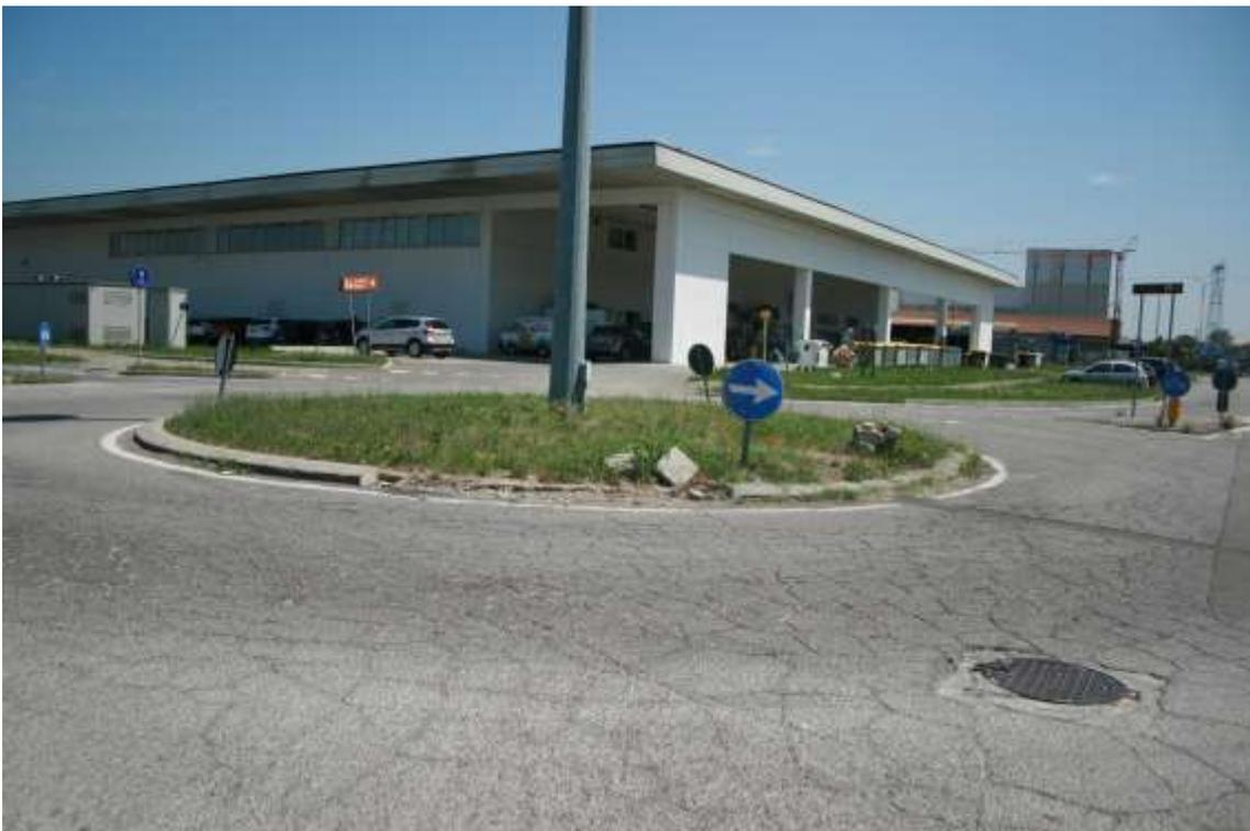
**Dettaglio corona giratoria – cordolature ammalorate ed assenti**
