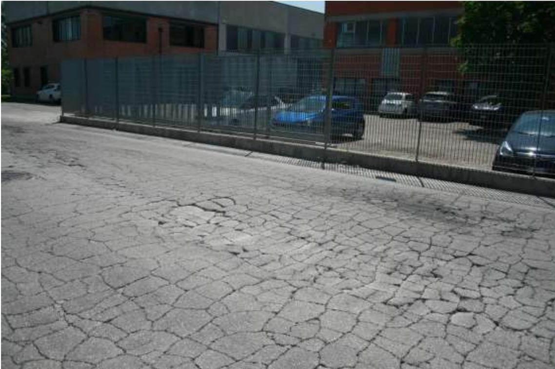
**Dettaglio ammaloramento manto di usura che comporta infiltrazioni nella sottostante fondazione
