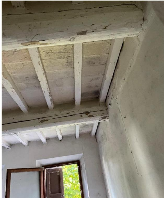
**2b) Setti non segnalati e presenza di travi strutturali**
