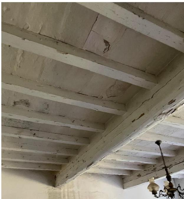
**3b)** Setti non segnalati e presenza di travi strutturali
