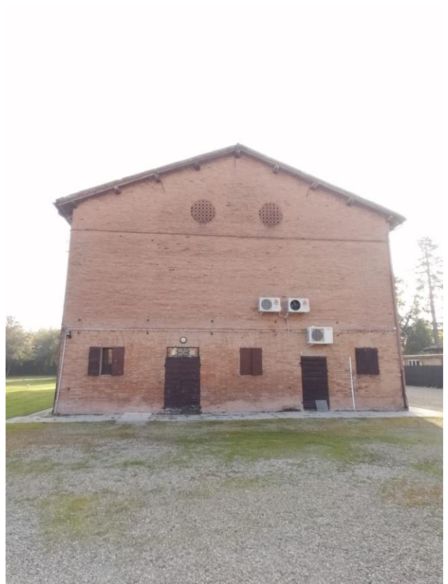
Foto 4 – Fronte Ovest stato di fatto
