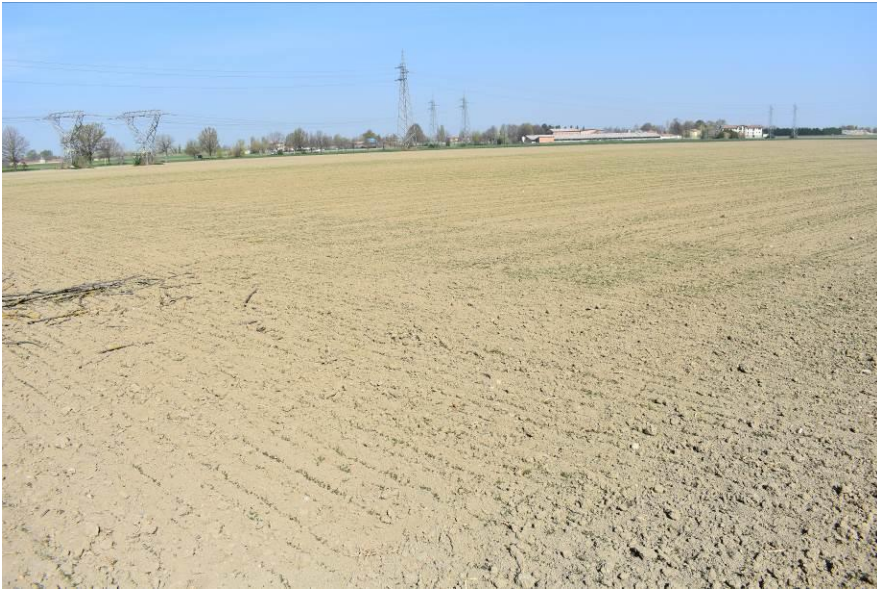
Fig. 63.10 area ad ovest della casa diroccata in cui verrà realizzato l'argine dell'ampliamento della cassa d'espansione laterale vista da sud
