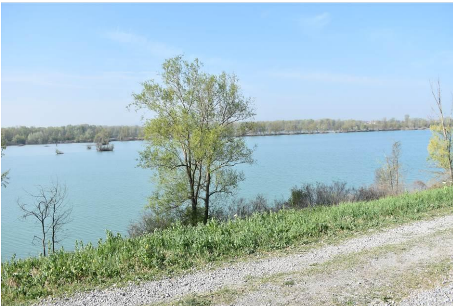
Fig. 63.2 Cassa d'espansione vista da nord
