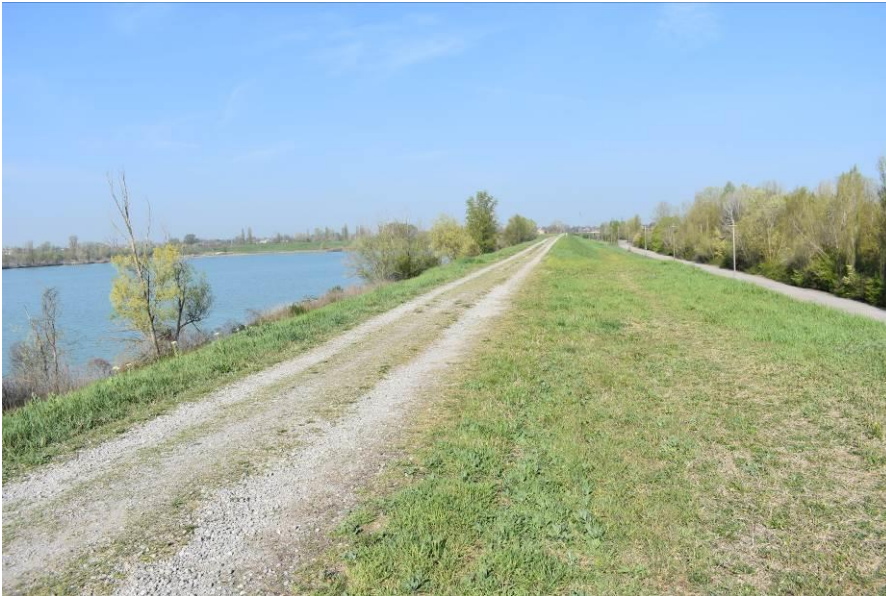
Fig. 63.1 arginatura lato nord della cassa d'espansione laterale, vista da sud-est
