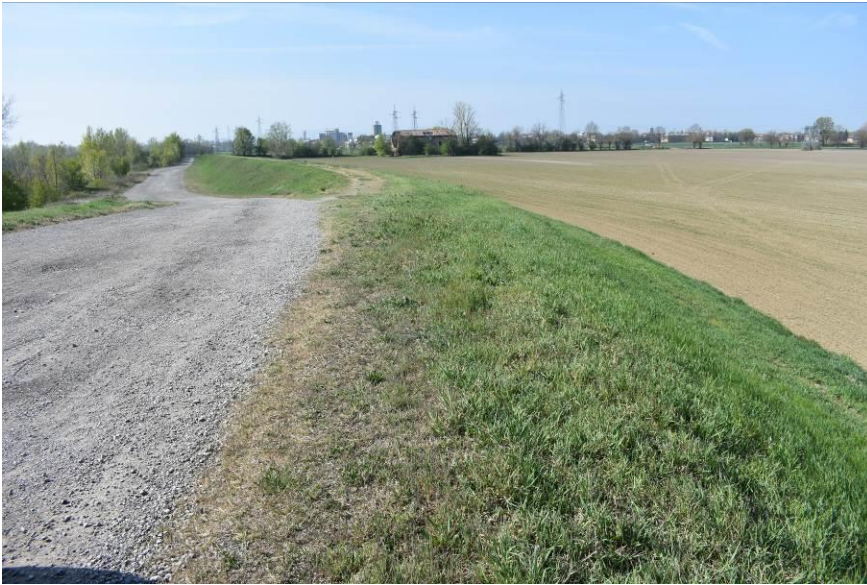
Fig. 63.7 area dell'argine della cassa attuale in cui verrà realizzato la soglia di sfioro dell'ampliamento della cassa d'espansione laterale vista da nord
