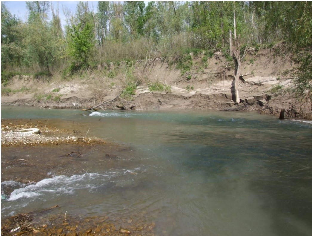
Fig. 60 Fiume Secchia: erosione in sinistra idrografica
