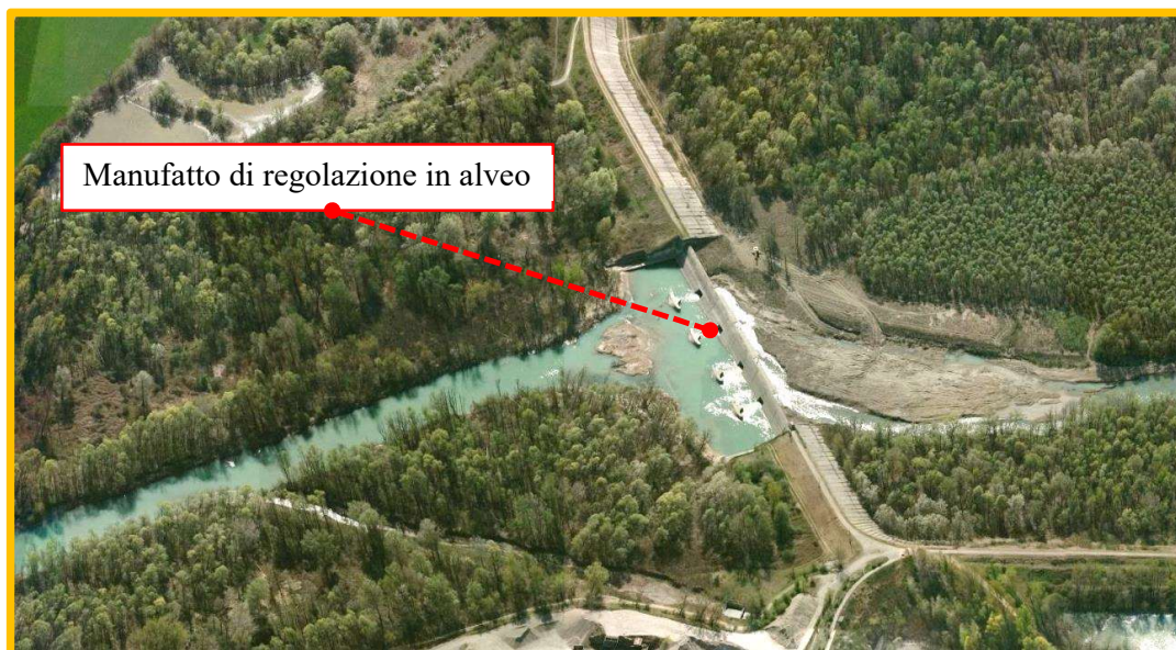
Figura 2.6: Area della cassa di espansione di Rubiera: traversa di regolazione.
