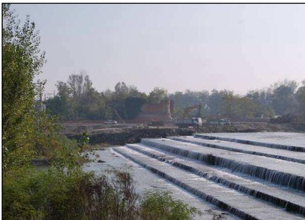
Opera idraulica (briglie) sul Secchia
