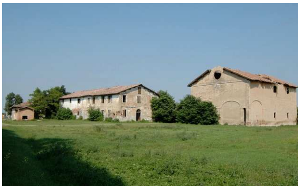
COMPLESSO RURALE A ELEMENTI SEPARATI
