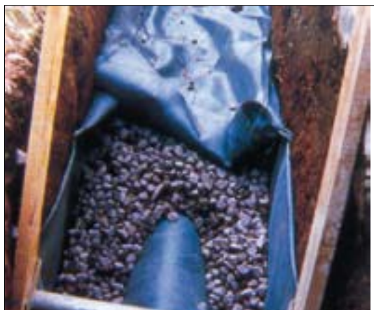
Figura 12: Una trincea d'infiltrazione (Fonte: EPA).
