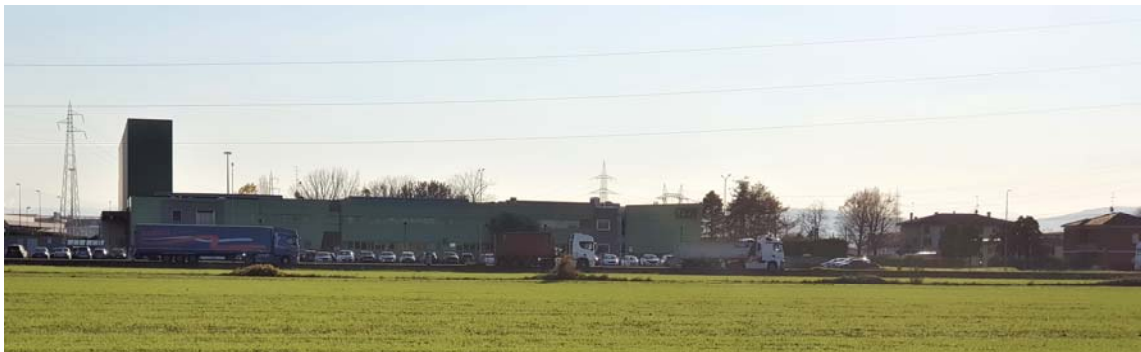
Foto 8 - Vista stabilimento UDOR a Sud
