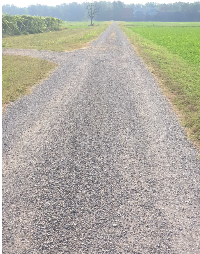
Foto 3 - Parte viabilità esistente lato Est
