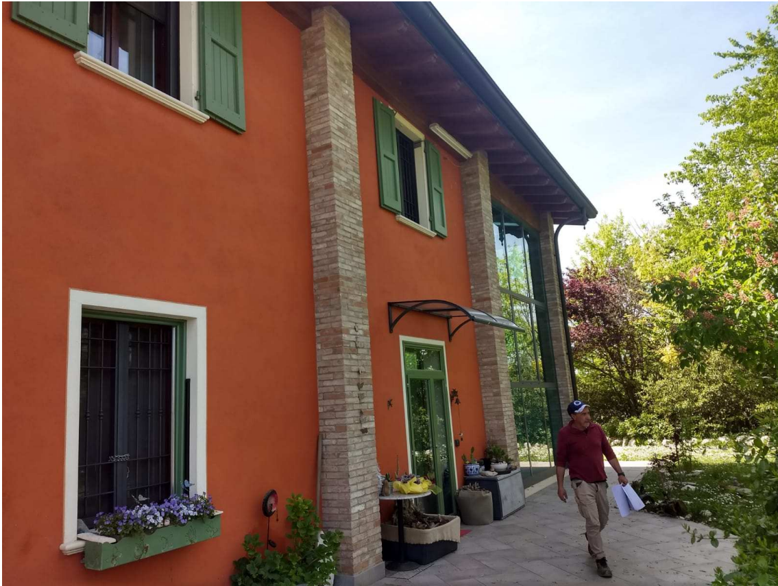
Foto 7 PROSPETTO NORD CON PENSILINA IN ACCIAIO E VETRO
