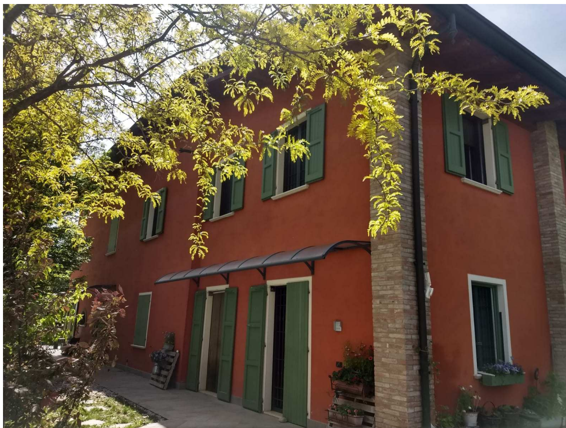
Foto 5 PROSPETTO NORD-EST CON PENSILINA IN ACCIAIO E VETRO
