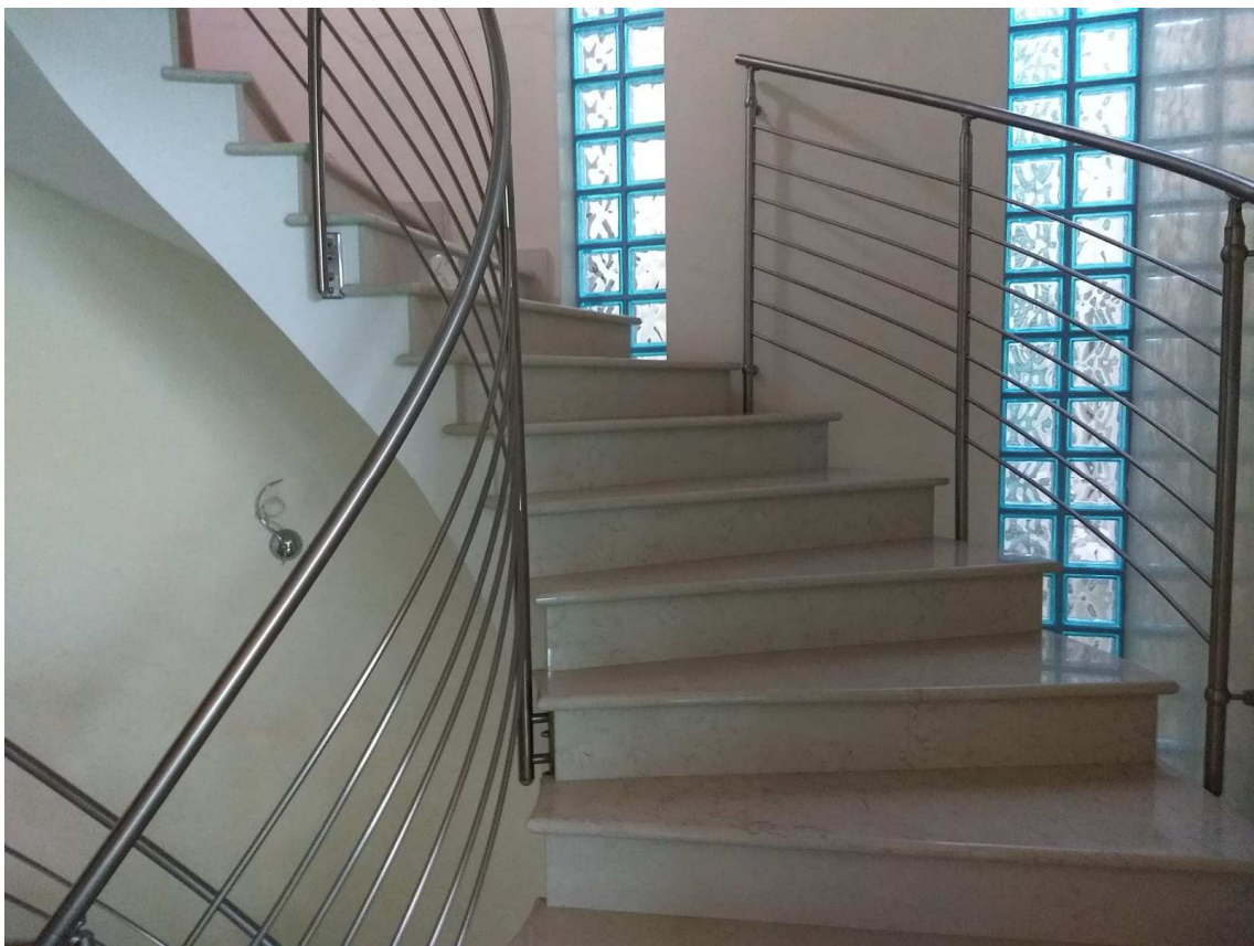
Foto 12 PARTICOLARE VANO SCALA ALLOGGIO SUD PIANO TERRA
