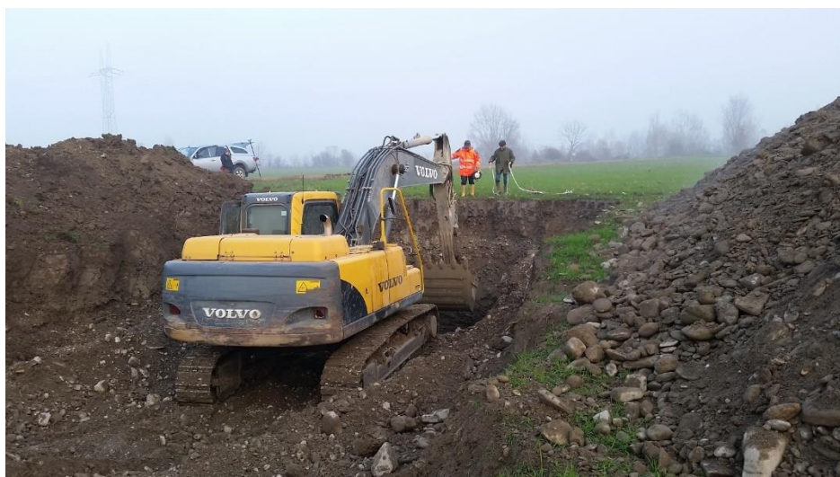
Figura 34. Sulla destra in evidenza il cumulo in preparazione con angolo di riposo > 40°.
