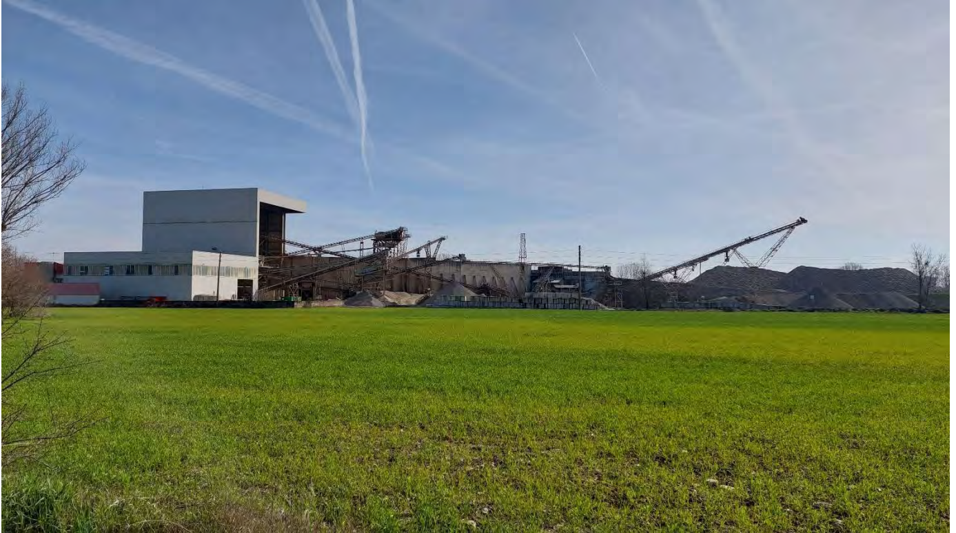
Foto 1. Area di cava – vista da ovest
